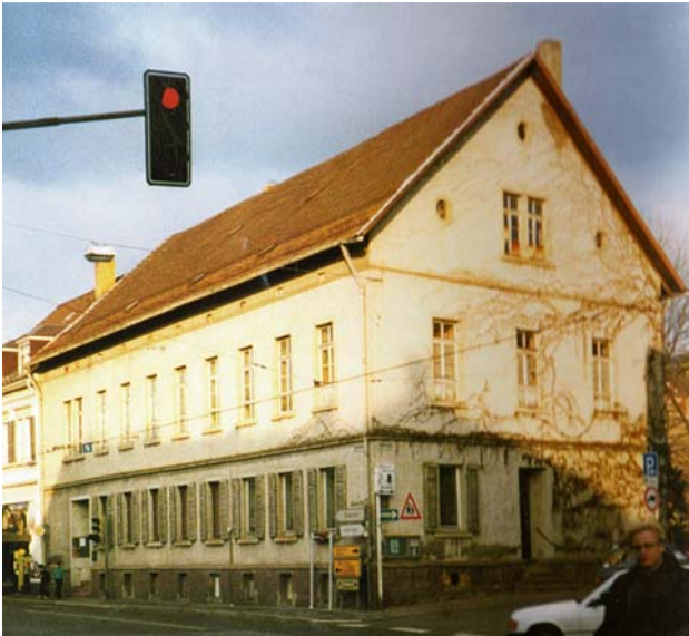
Seit 1954 Gemeindehaus mit Kindergarten
