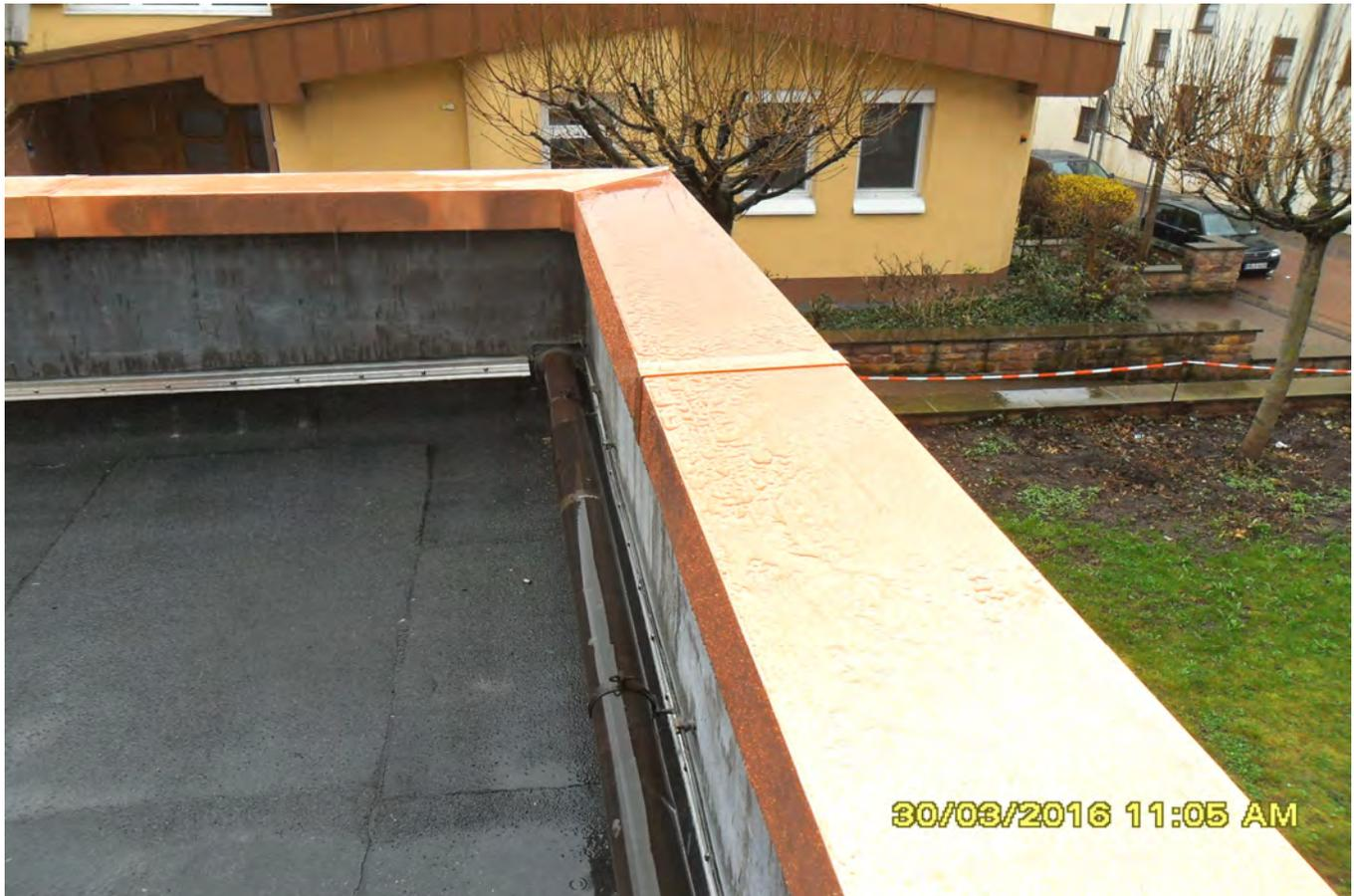
danschlusschienen beginnen. Um die Dichtigkeit auch von der Brüstungs-Oberfläche für die Zukunft zu gewähren, wurde diese mit einer Kupferabdeckung, mit einer Breite von 50 cm und einer Gesamtlänge von 19,50 Meter versehen. ( Siehe Bilder ) Dadurch sowie durch die neuen Sanie-
